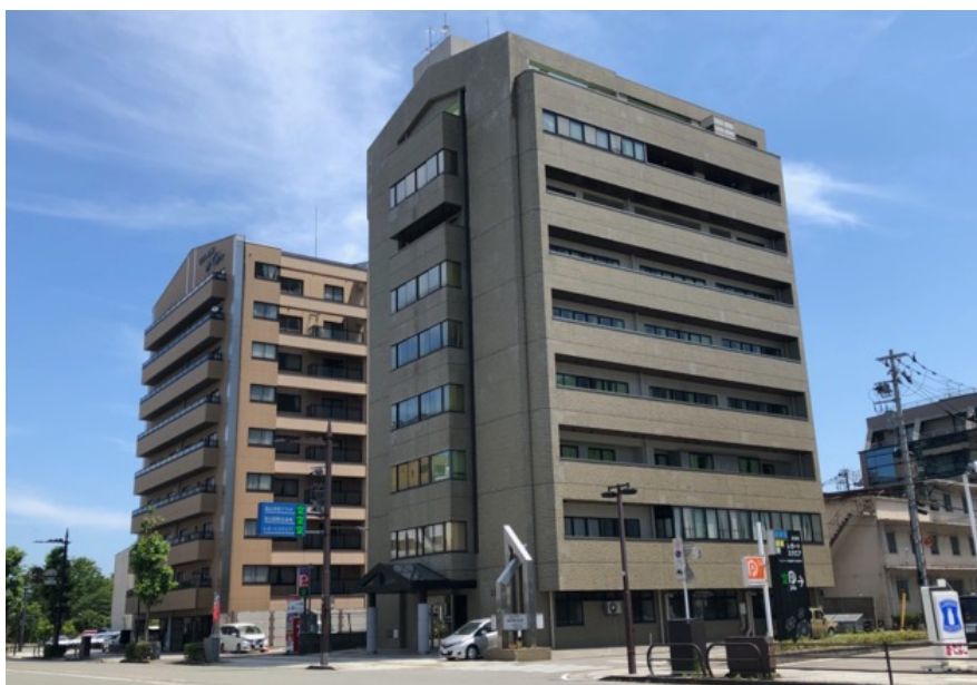
富山リハビリテーションホーム（右）外観
